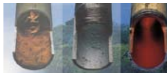
Vor und nach der Sanierung: Rohre wie neu!
